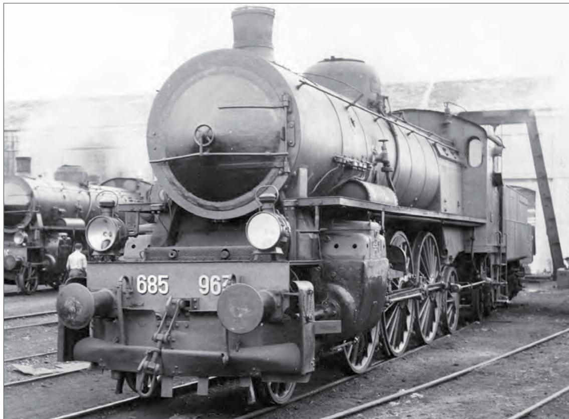
Locomotiva a vapore delle FS 685.963 (ex gruppo 686.005-034), con distribuzione Caprotti, costruite nel 1926/28 da OM e CEMSA. Il modello riproduce l'unità ex 686.013, nella condizione di fine carriera, assegnata al deposito di Udine.
